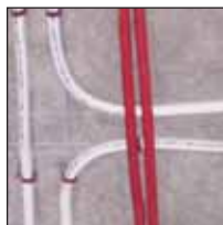
L'attrito mantiene saldamente la Linian Clip in posizione.
