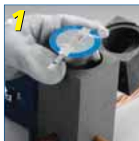
1 Włóż wkład CADWELD PLUS do formy.
