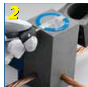
2 Podłącz zacisk jednostki sterującej do taśmy zapłonowej.
